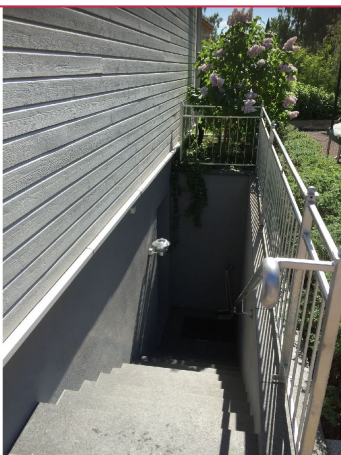
Trappeoppgang fra leiligheten
