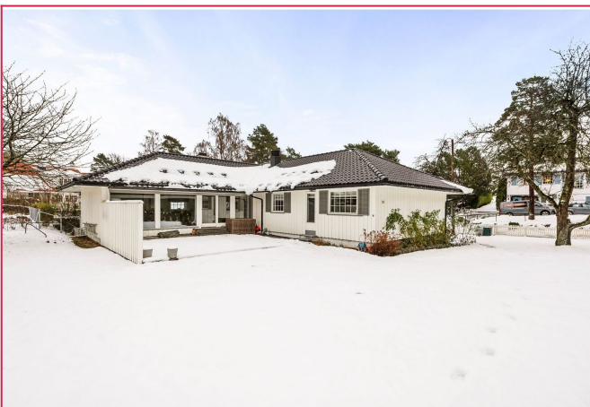
Fasade fra hagen med terrasse
