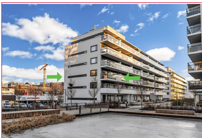
Fasade - leiligheten ligger i 3. etasje
