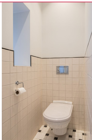
Tolaett med skyvedør på bad nr 2.
