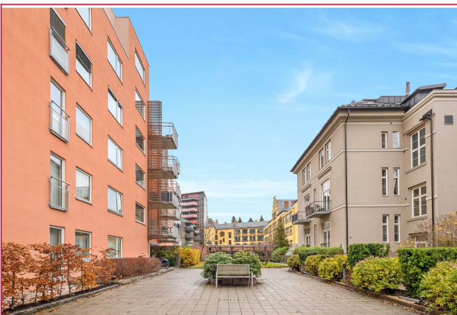
Fasaden sett fra bakgården.
