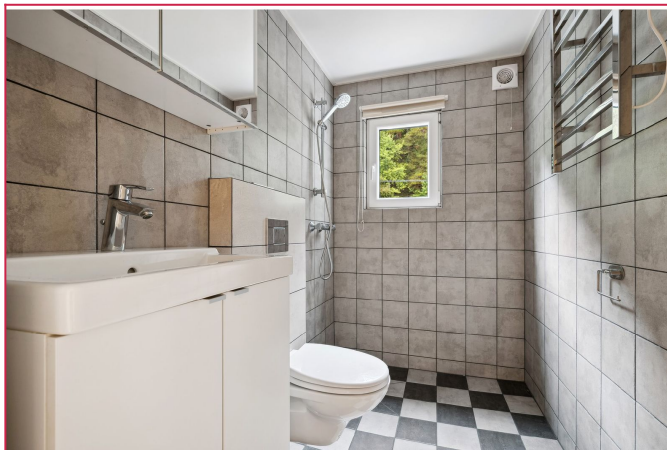
Nyere flislagt bad med dusjhjørne, toalett og servant
