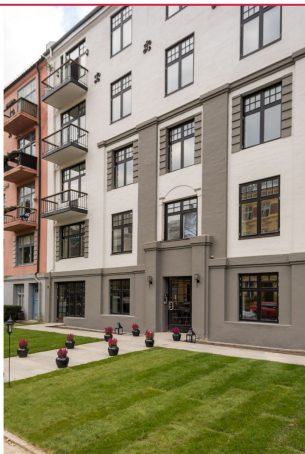
Pent opparbeidet uteområde
