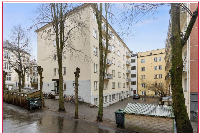
Fasade - Inngang er døren til venstre på bilde
