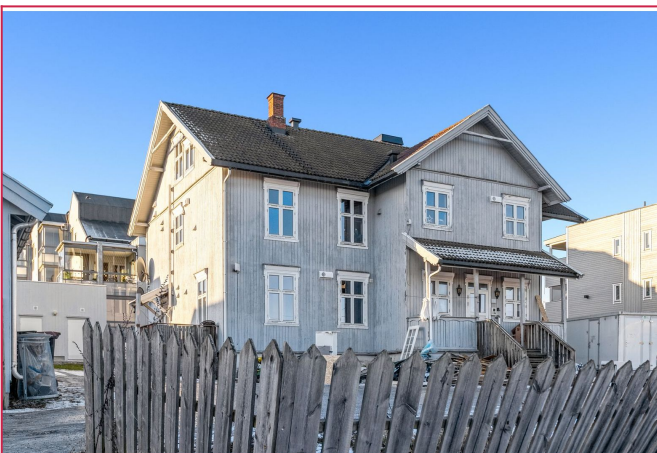
Fasade og utsiden av eiendommen blir også gjort penere til våren.
