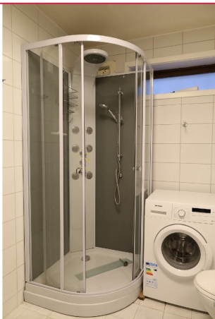
Bad med wc, dusjhjørne og installert vaskemaskin.
