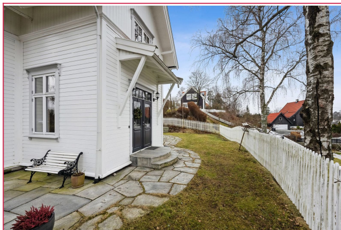
Inngangsparti mot nord
