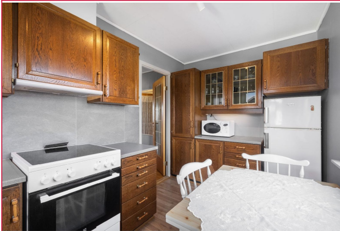
Kjøkken - bordet og kjøleskapet er blitt byttet ut med nye
