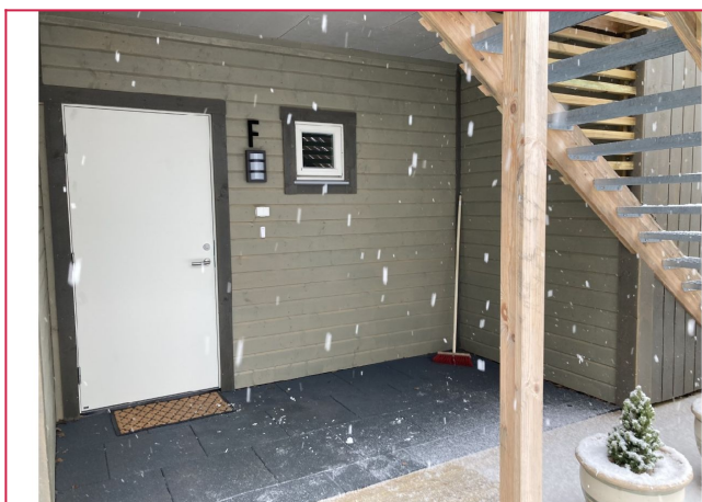
Overbygd og skjermet inngangsparti
