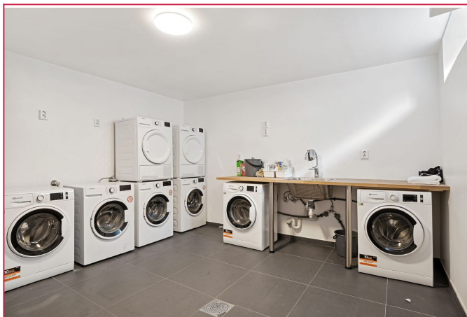
I kjelleren er det ett stort felles vaskerom.
