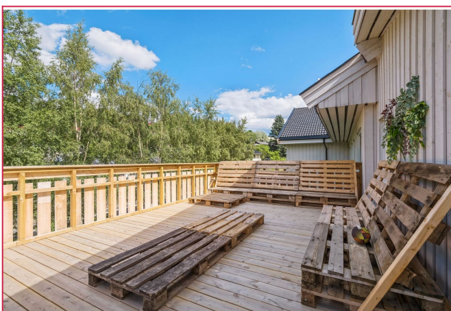
Terrassen har enkel innredning.
