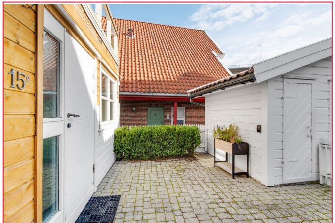
Inngangsparti med tilhørende utvendig bod
