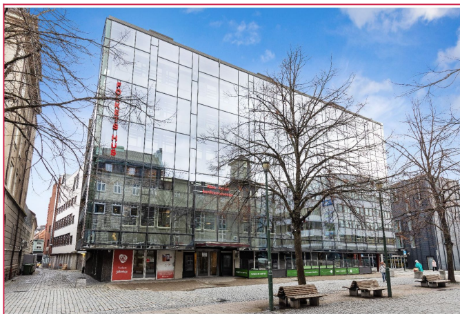
Fasade av Folkets hus- Hyblene ligger i 5 og 6 etasje
