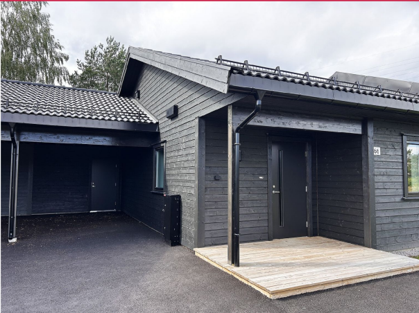
Inngangsparti med overbygg og carport
