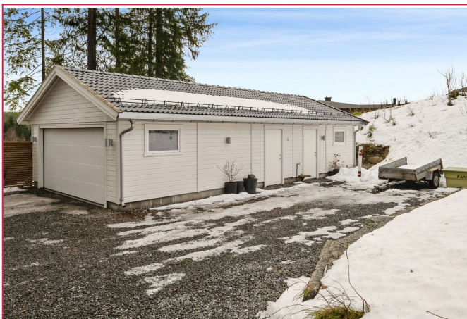
Oppstillingsplass for bil
