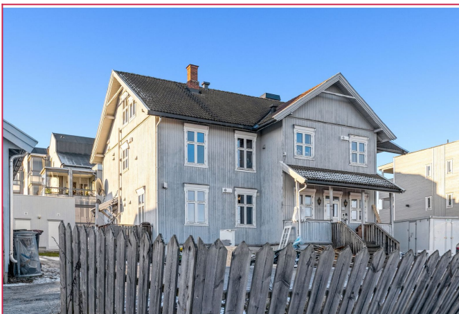
Fasaden på bygget samt uteområder blir også pusset opp til våren.
