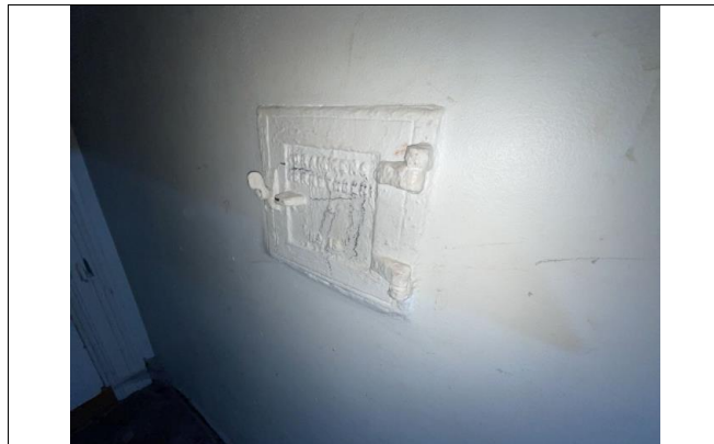
Bilde fra befaringsstidspunktet.
