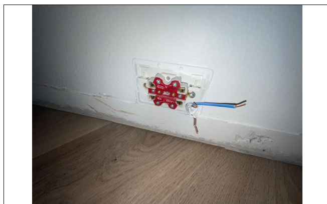
Bilde fra befaringsstidspunktet.
