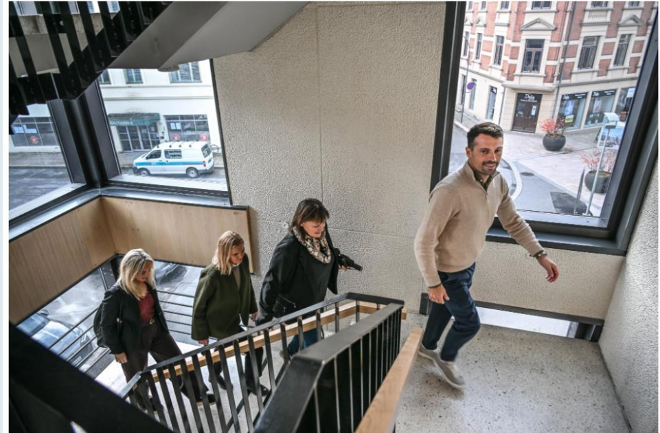
Trappeløpet i Brage Fram-gården var karakteristisk med metallspiler fra kjeller til loft da Kynningsrud Eiendom overtok. «Et apebur» kaller Hilde Nomell Kynningsrud (lengst til venstre) det i dag. I dag fremstår trappeløpet som langt luftigere. Foto: Geir A. Carlsson
