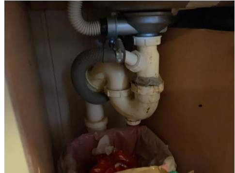
Tettemasse i skjøter
