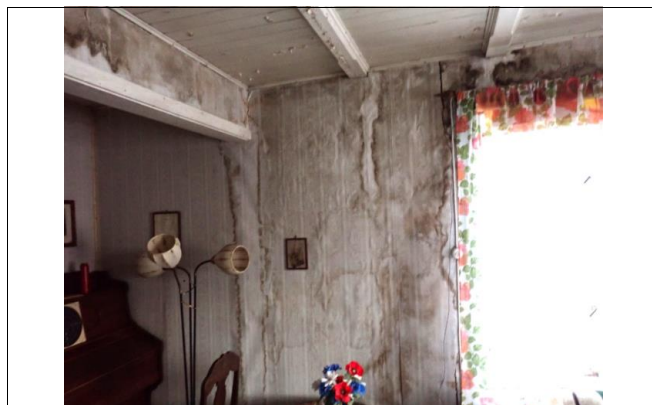
Stue - yttervegg mot øst.
