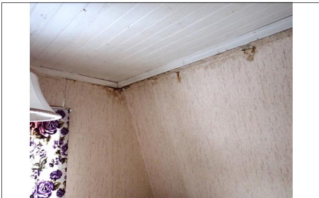
Soverom - Skrå takdel mot sørvest.
