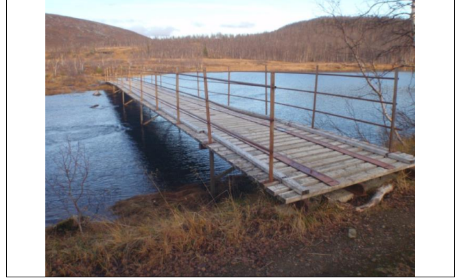
Bru over utløpet fra Nergluggvatnet.
