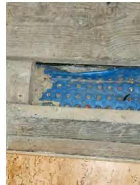
Det er synlig grunnmursplast under sponplater, usikkert hvor dette er lagt
