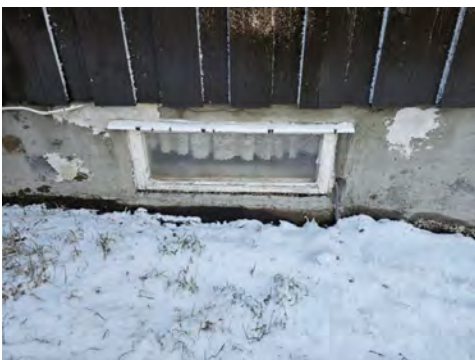
Kjellervindu uten beslag under
