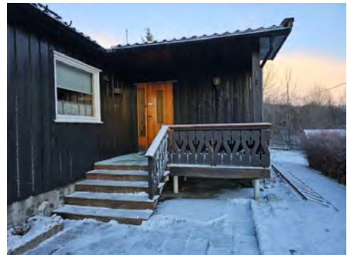
Balkong ved inngang
