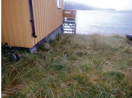
Terrengarrondering med fall inn mot grunnmur.
