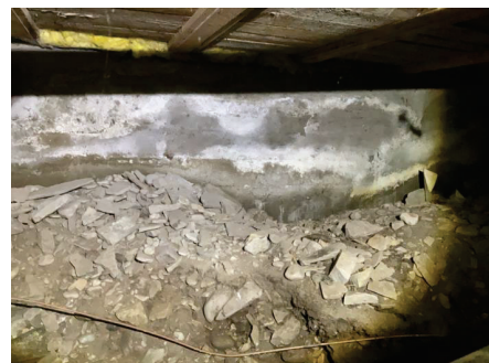
Kalkutfelling langs grunnmur.
