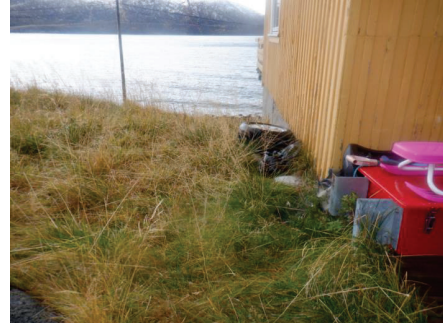
Terrengarrondering med fall inn mot grunnmur.
