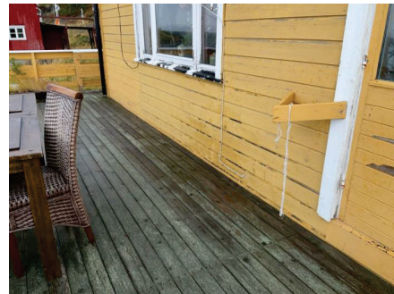
Markant panelslitasje.
