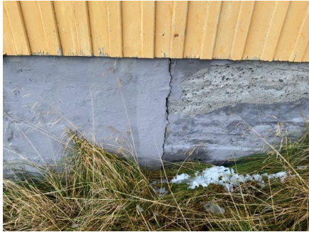
Østfasade vertikalt brudd.
