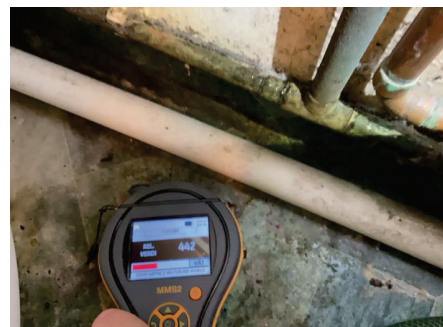
Markerte utslag på måleindikator mot undergulv.
