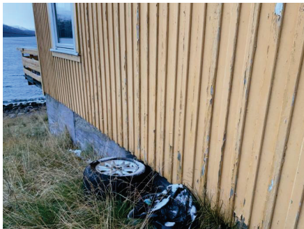
Markant panelslitasje.
