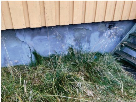
Vestfasade vertikalt brudd.
