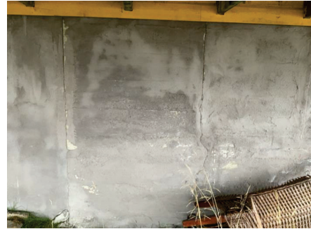
Sørfasade vertikalt brudd.
