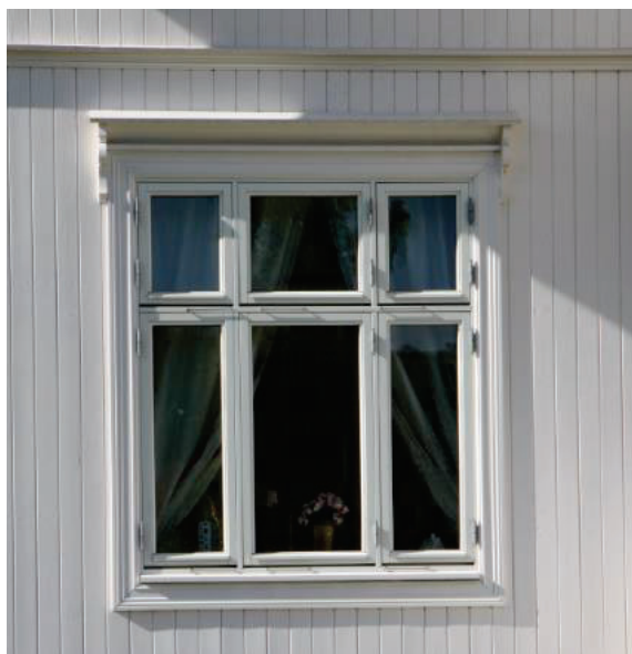
Bilde 20. og 21. Krysspost- og dobbeltkrysspost vindu.
