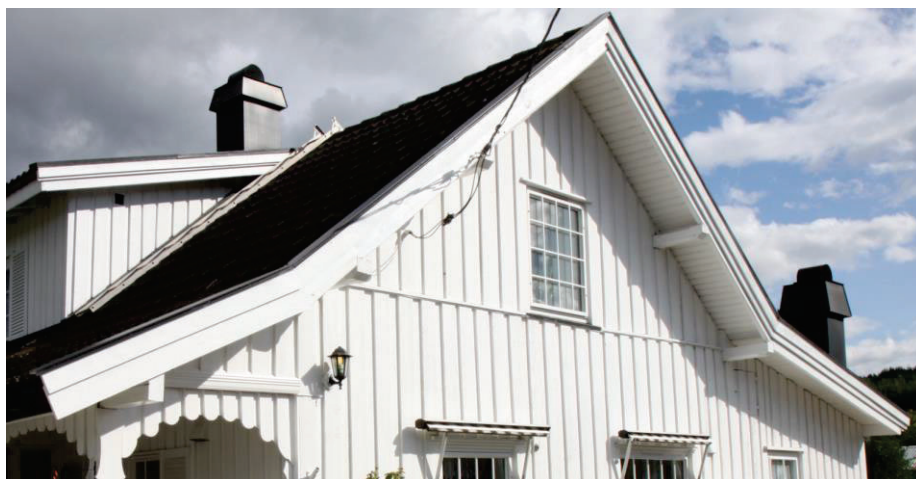
Bilde 2. Takbjelker under saltaket er tydelig med detaljer. Takbjelker under den nedsenket delen har ingen detaljer og er felt i fasaden.
