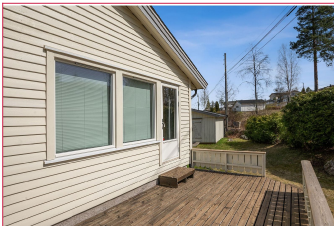
Terrasse med gode solforhold
