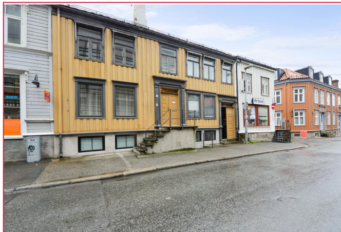
Fasade: Leiligheten ligger til venstre i 2.etg
