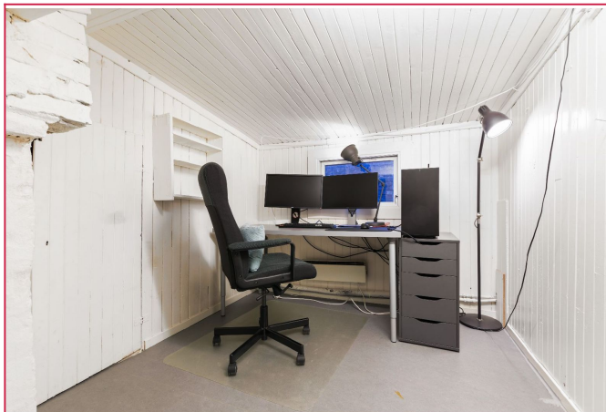
Hemsrom. Tidligere møblering ikke godkjent pga brannregler, kan brukes som bod/oppbevaring
