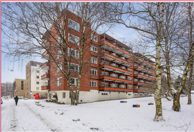
Fasade - Ensjøveien 27 B
