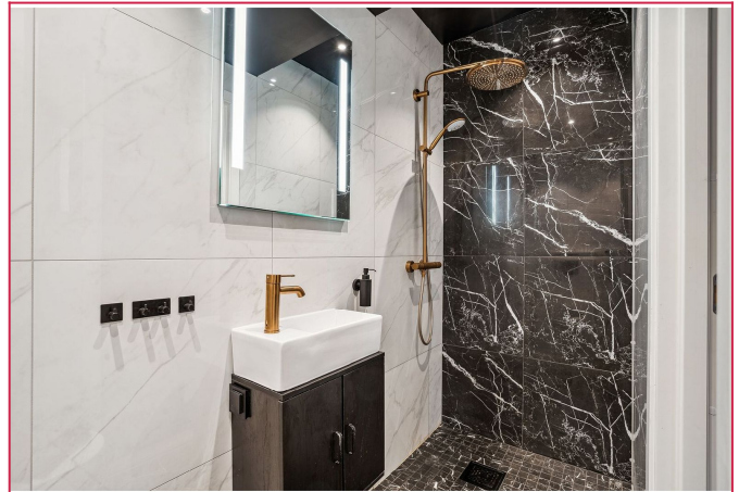
Rålekkert bad med varmekabler
