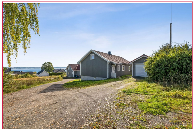
Stort uteområde med garasje og biloppstillingsplass.
