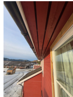
Synlige luftespalter i raftekasser ved overgang tak/vegg
