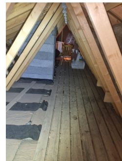
Synlige luftespalter i raftekasser ved overgang tak/vegg
