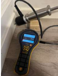
20% fukt målt med pigg i tre på toalettrom.
