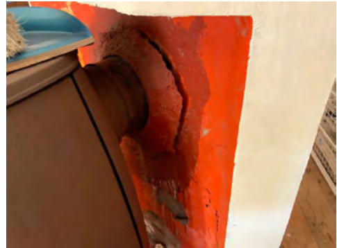
Større sprekke/utetthet.
