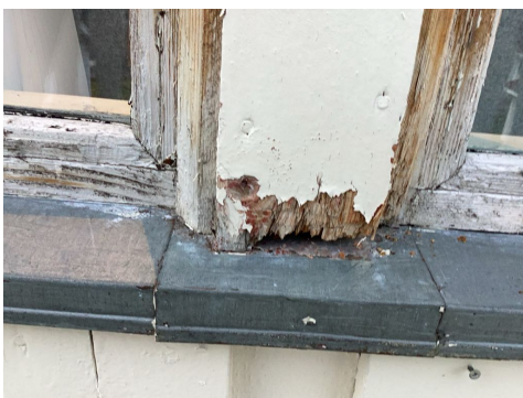
Eksempel på råteskade ved omramming
