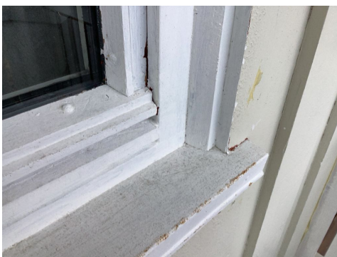
Eksempel på råteskade ved omramming
