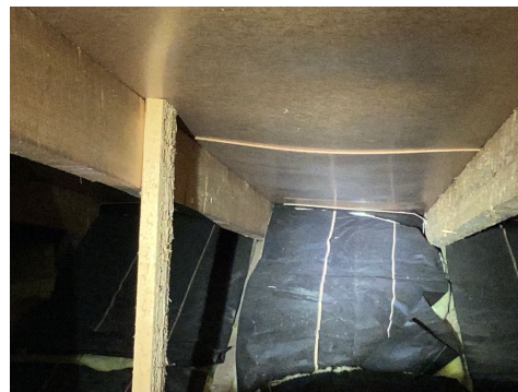
Eksempel på manglende lufting ved raft
