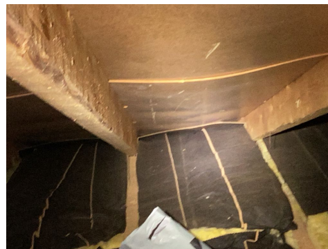
Eksempel på manglende lufting ved raft
