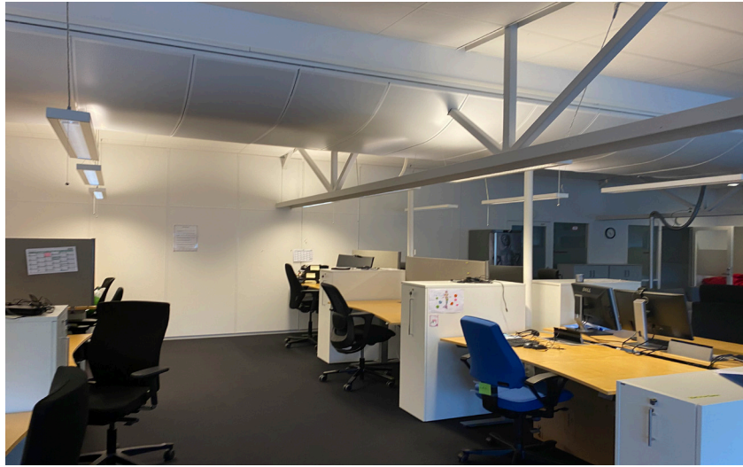
God standard på innemiljø med akustikk-himling og teppeflis på gulv
