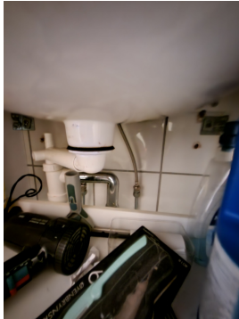
Bilde fra servantinnredning på badetrom.
