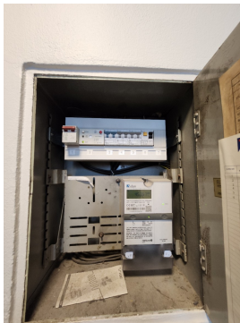
Automatsikringer og måler i sikringsskap plassert i felles trappegang.
