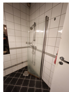
Mekanisk avtrekk i felles kanal i bygningen.
