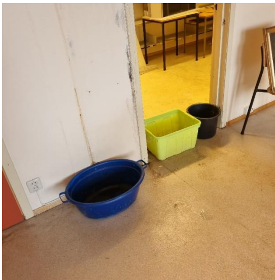
Store skader etter lekkasje gjennom taket-. Påreknes store skjulte skader i vegg og tak.
