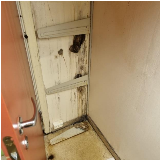
Bilda viser sopp og råteskade der det er lekkasjer.
