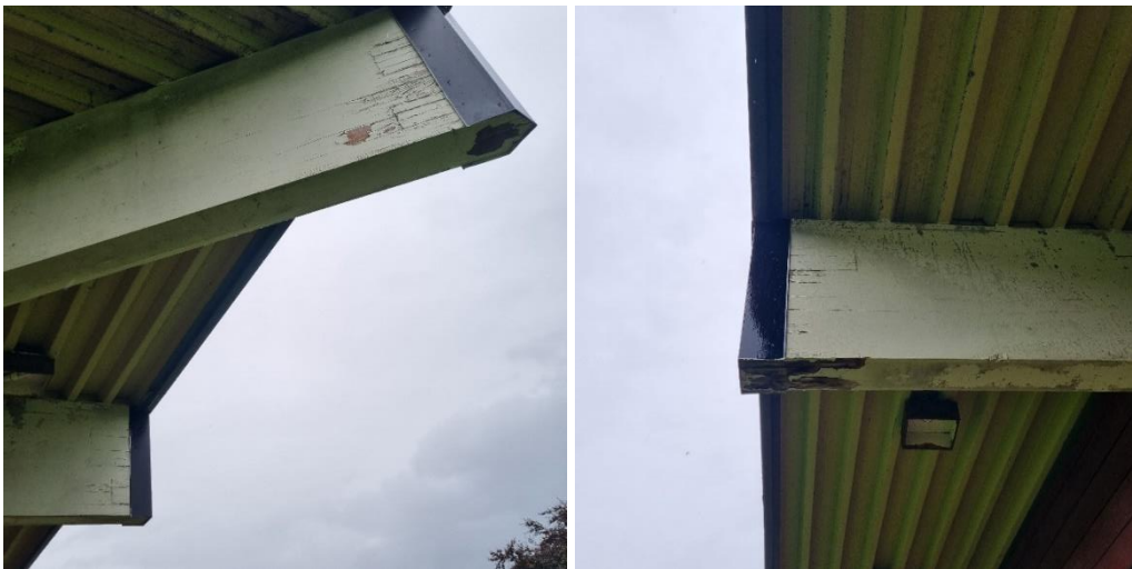
Råteskade i endane på laminerte tredragere
