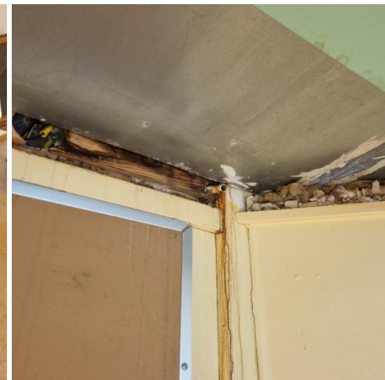
Store skader etter lekkasje gjennom taket-. Påreknes store skjulte skader i vegg og tak.
