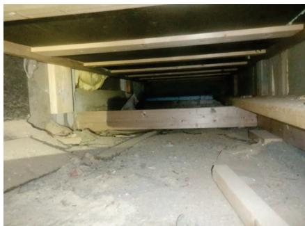
Kryprom inn under tilbygg gang.
