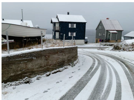
Rekkverk/-sikring mangler.
