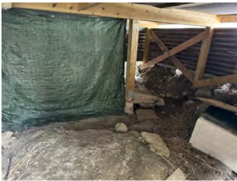
Pilarer til mark under tilbygg.
