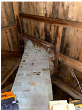
Fukt/råteskader i takkonstruksjonen.
