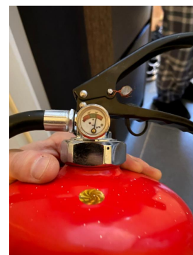
Bildet viser pulverapparat, utgått på dato.
