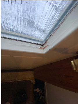
Bildet viser flakkende maling på glasslist.
