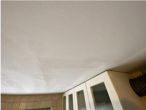
Bildet viser himling på kjøkken.
