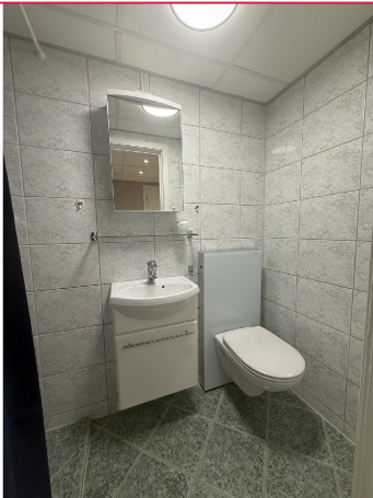
Bad med toalett og dusj
