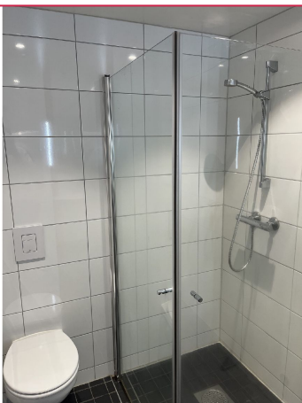
Dusjkabinett og vegghengt toalett
