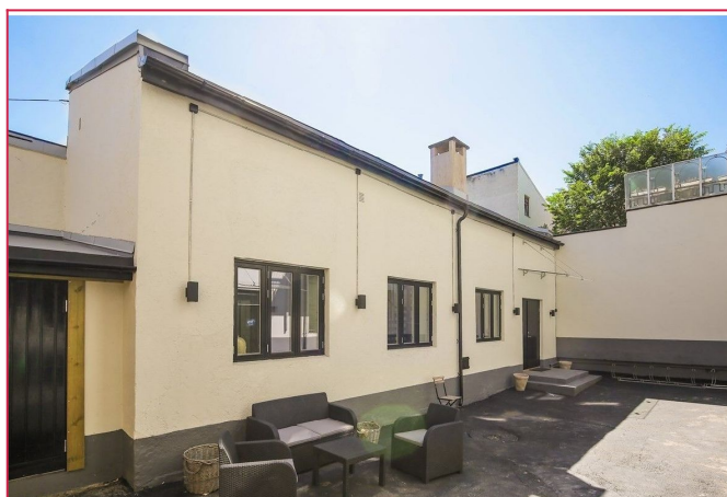
Leiligheten er plassert i egen bygning.
