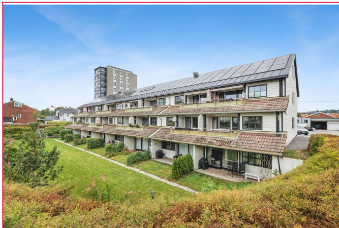
Fasade mot sør. Boligen ligger i 2.etasje fra denne siden, men i 1.etasje fra inngangssiden.
