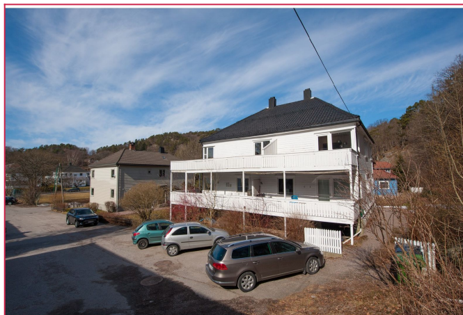
Fasade. Boligen er malt siden sist, fargen utvendig i dag er grå.
