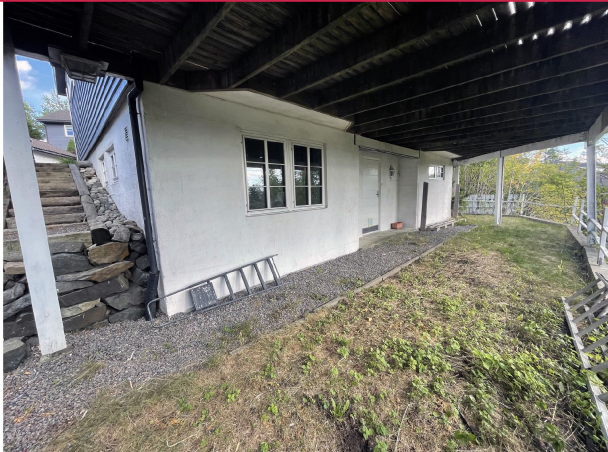
Egen inngang i underetasje.
