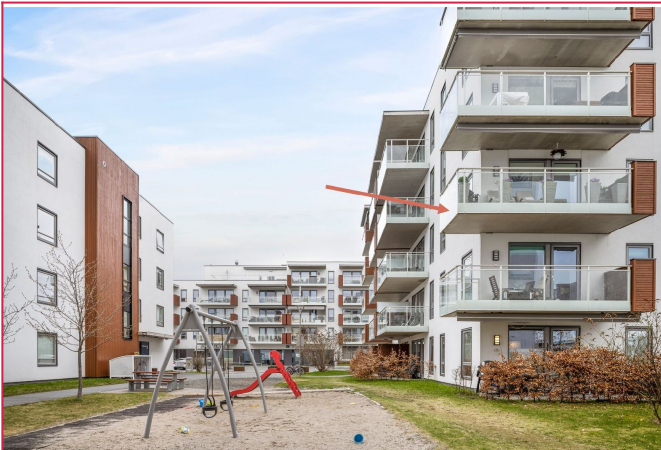
Balkongen ser du til høyre i bilde i 3 etasje.
