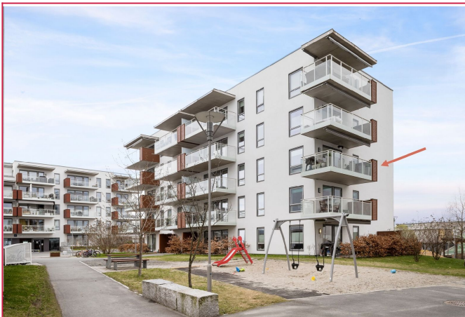
Regattaveien 8 - Balkongen ser du til høyre i bilde i 3 etasje.
