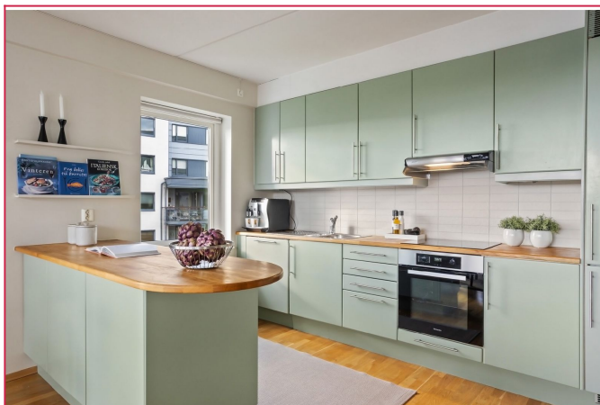
Kjøkkeninnredning med glatte fronter, benkeplate av heltre og oppvaskum av stål
